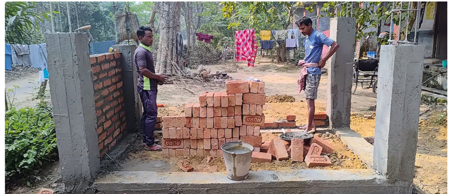
Die Instandsetzungsarbeiten im Krankenhaus von Bankura haben bereits begonnen. In den nächsten Jahren soll alles umfassend saniert und neu ausgestattet werden.
