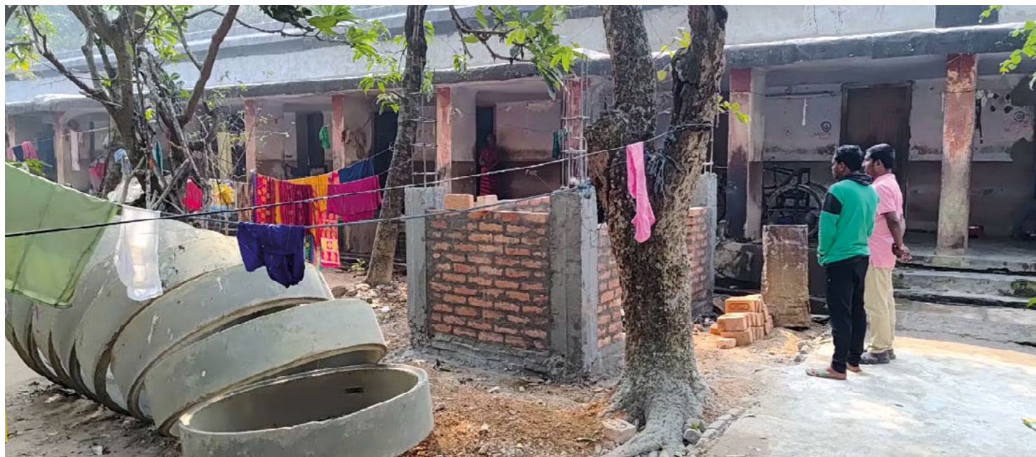
I lavori di ristrutturazione dell'ospedale di Bankura sono già iniziati. Nei prossimi anni l'intero edificio sarà completamente ristrutturato e dotato di nuove attrezzature.
