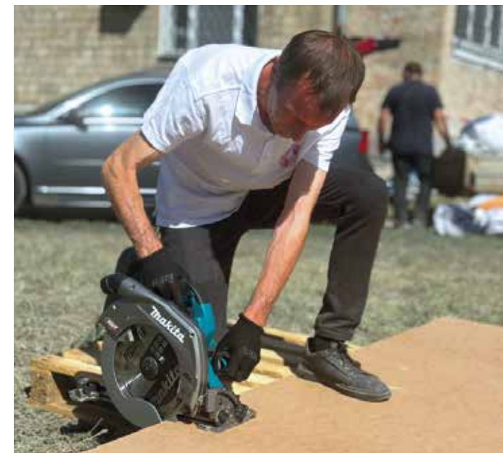
Die heftigen Angriffe richten viel Zerstörung an. Mit den Holzplatten, Isolierfolien und Werkzeug aus Südtirol können die Menschen die Schäden an Mauern und Fenstern in ihren Wohnungen schnell abdecken und sind so weiterhin vor Kälte und Niederschlägen geschützt.
